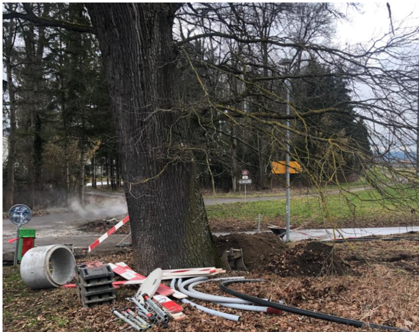
Solche Baustelleninstallationen stellen eine grosse Herausforderung für Bäume dar.
