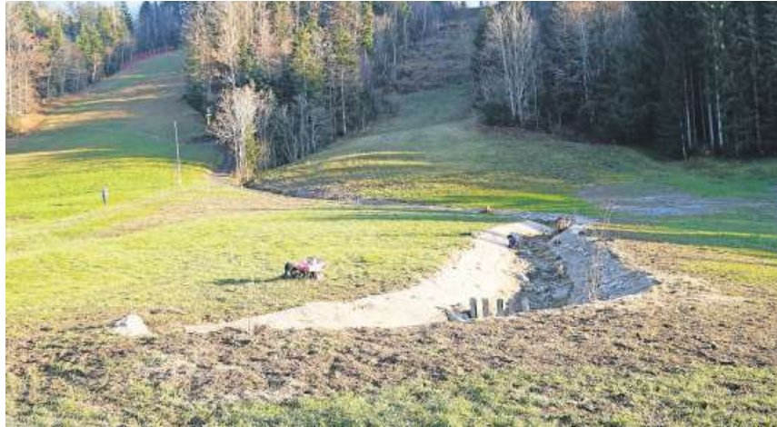
Der Felbachernbach wurde auf 100 Metern ausgedolt.
