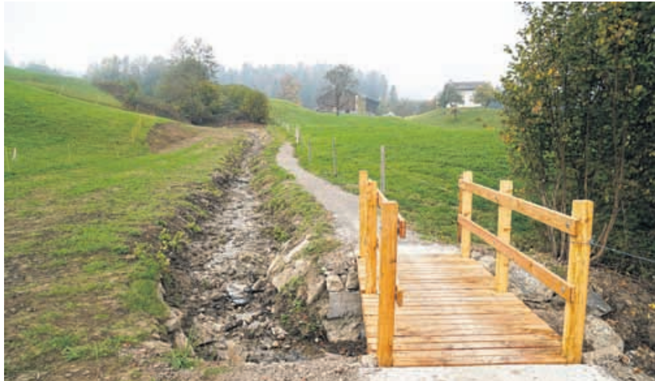
Das Pilgerwegbächli am Jakobsweg wurde revitalisiert.
