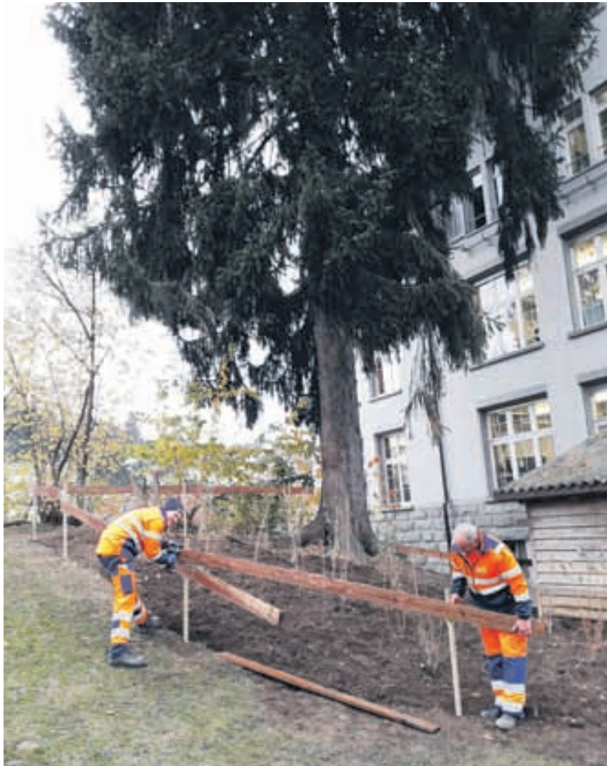
Das Werkhofteam auf der Schulanlage Wilen beim Errichten des Holzzauns, der die noch jungen Wildsträucher schützen soll.
