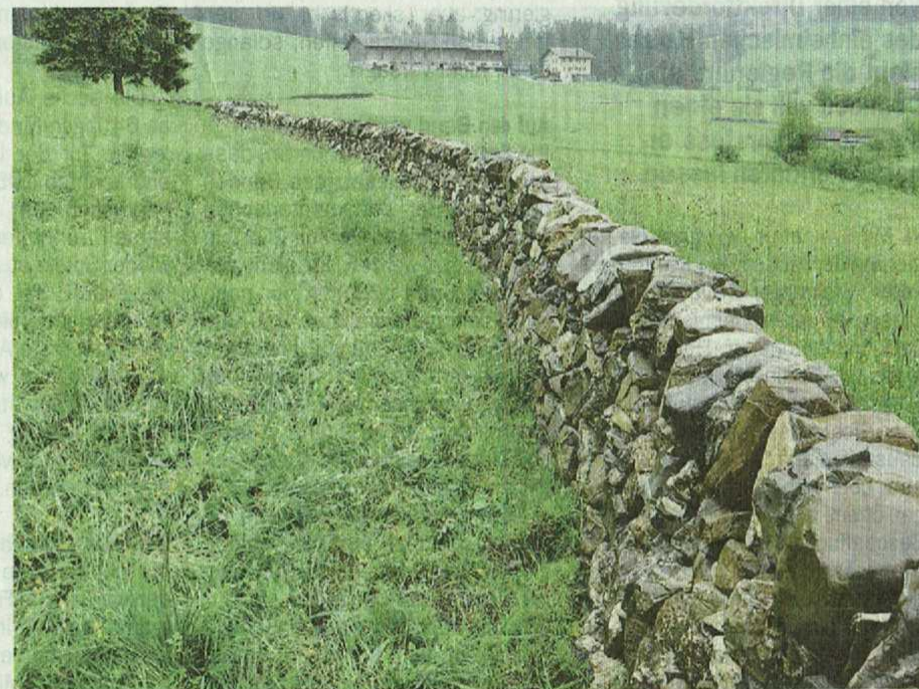
Rund 220 Meter lang ist die Trockensteinmauer; sie passt sich dem Gelände an. Sie ist zugleich schön und funktional.
