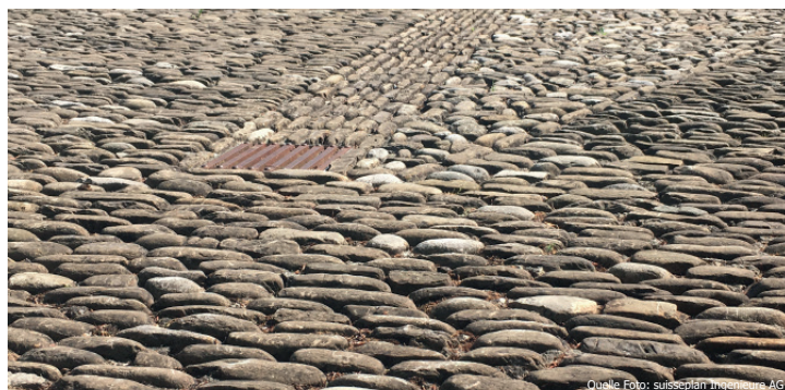
Unvermörtelte Pflastersteinbeläge sind attraktiv und wasserdurchlässig.
