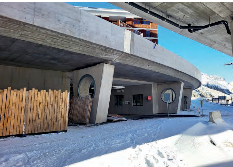
Ansicht Pfeiler 3 und 4
