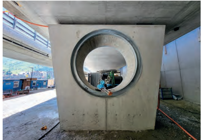
Pfeiler mit Lichtringeinlage
