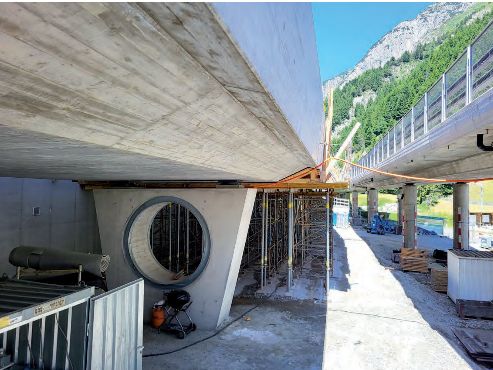
Brücke «Fly Over», Andermatt
