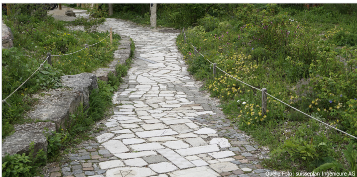
Unversiegelte Beläge lassen Regenwasser versickern.
