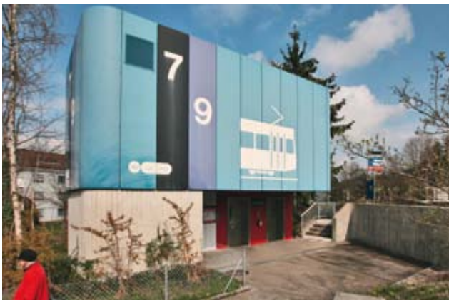
2: So sieht das Aussenbauwerk der Haltestelle Tierspital heute aus.
