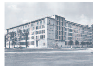
1940 Schweizerische Lebensversicherungs- und Rentenanstalt Architekten: Gebrüder Pfister
