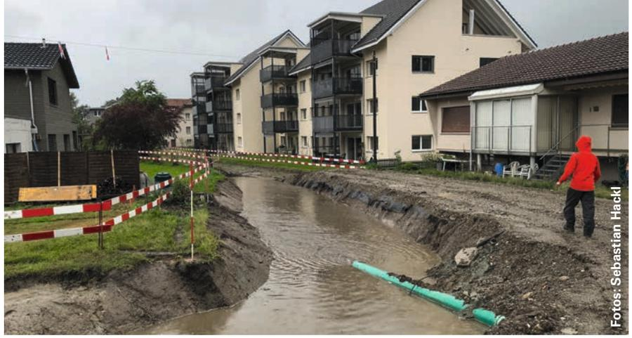
Ein kleines Hochwasser während des Baus im Juni 2020 zeigte, dass der Bachlauf nicht zu gross dimensioniert wurde (Abschnitt Trottingasse bis Hauptstrasse).
