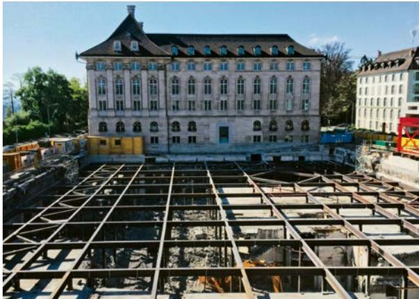
Spriessplattform: Um auch die Untergeschosse rückbauen zu können, musste die bestehende Schlitzwand – der ehemalige Baugrubenabschluss des Vorgängerbaus – gehalten werden. Eine **tischartige Stahlkonstruktion** steifte die Baugrube während des gesamten Rück- und Wiederaufbaus satt aus.
