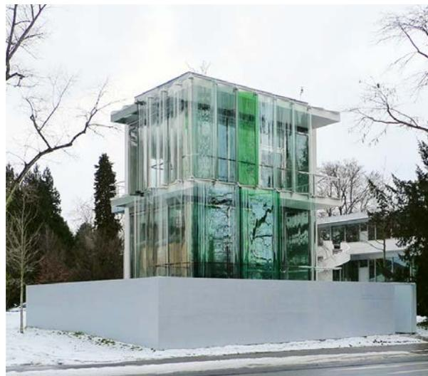
1:1-Mock-up mit verschiedenen Varianten für die Wellengläser der Fassade.
