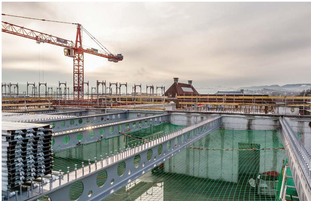
**Perforierte Träger mit Kopfbolzen für den Verbund:** Das Tragwerk des Gebäudes besteht über Terrain aus einem Skelettbau mit vorfabrizierten Stahlstützen und gedruckten Stahl-Beton-Verbunddecken. Um die Medien in der reduzierten Konstruktionshöhe unterbringen zu können – die Konstruktionshöhe inklusive untergehängter Decke beträgt bei Spannweiten von bis zu 14 m nur 75 cm –, sind alle Träger systematisch perforiert.
